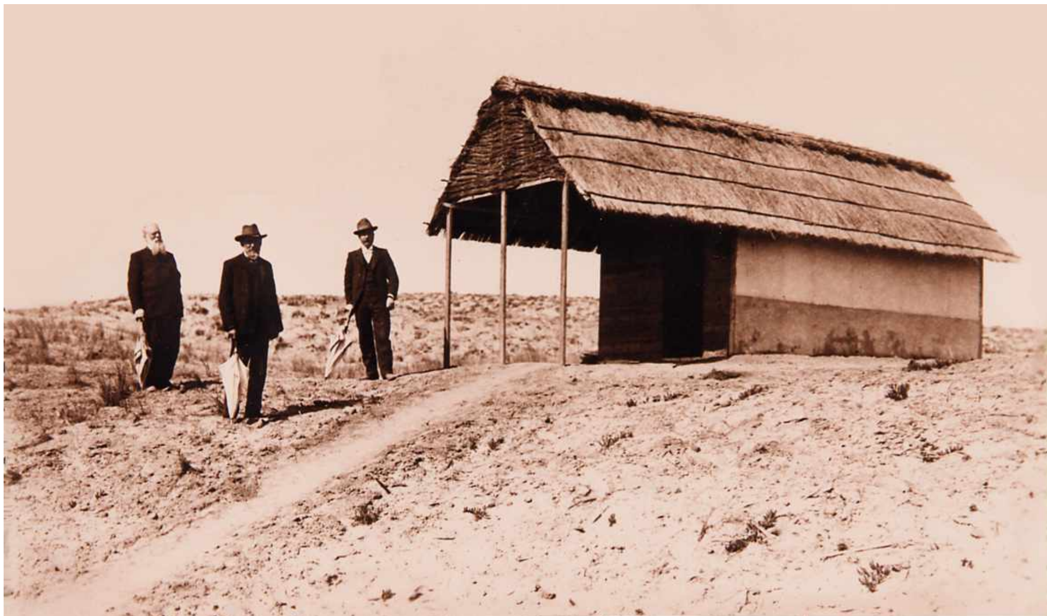
Caseta desmontable, formada con tableros de madera y cubierta de barrón, para refugio de los obreros: de izquierda a derecha los Ingenieros D. Ricardo Loelorniu, D. Jose Sainz de Baranda y D. F. co Miral
