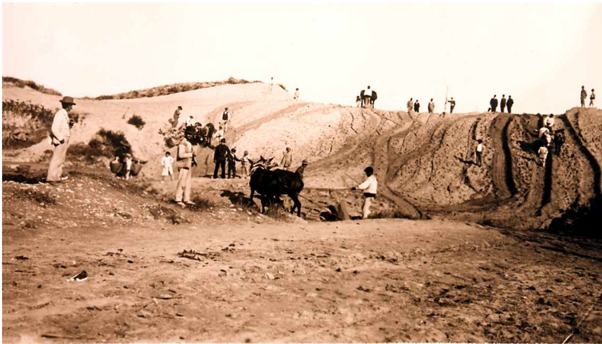
Desmonte de arenales con travillas o robacleras, tirados por mulas, para la explanacion del camino del mar. Año 1903
