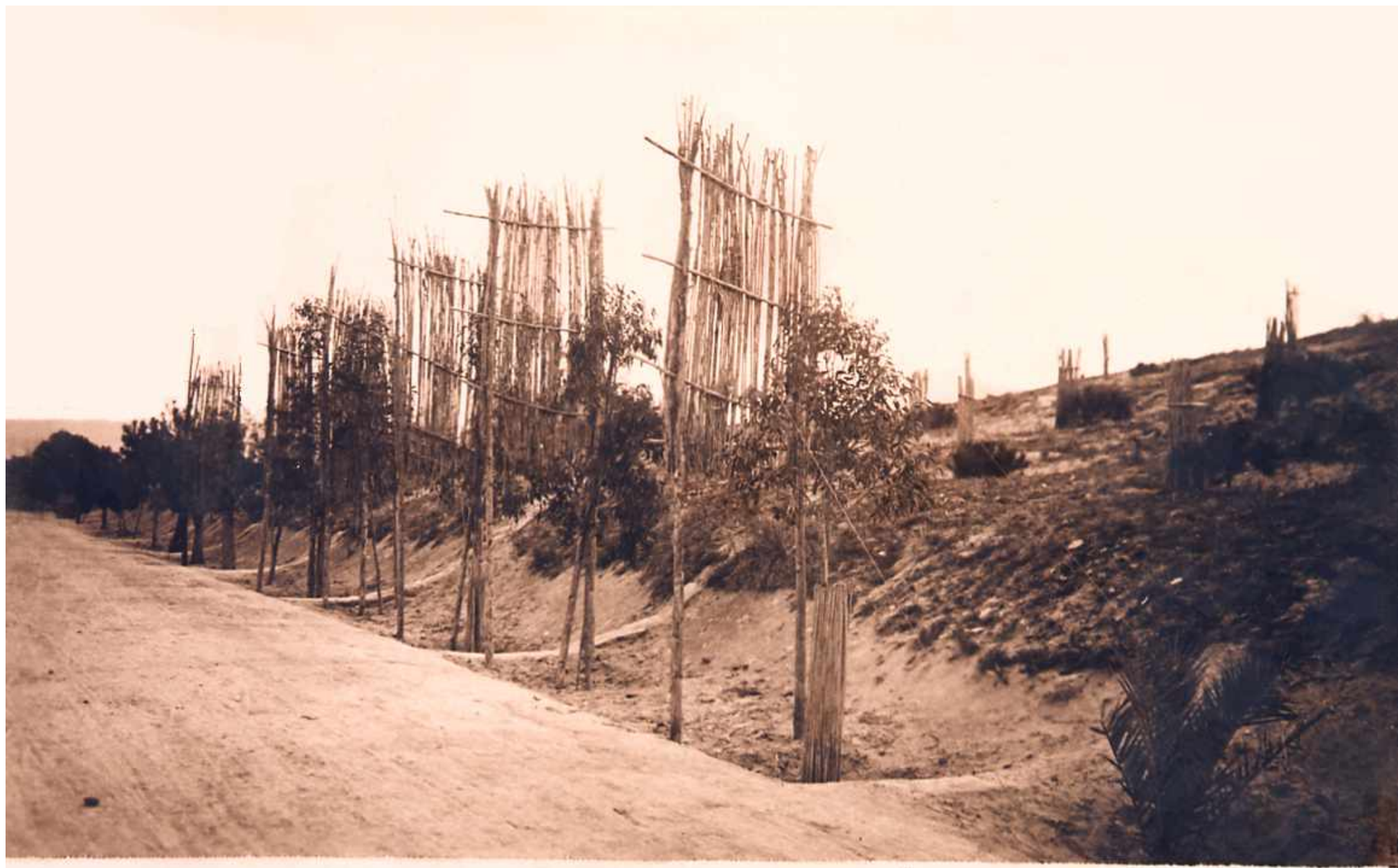
Proteccion, con cañizos, de los Eucalyptus de la carretera, en los primeros años, contra el viento del mar.
