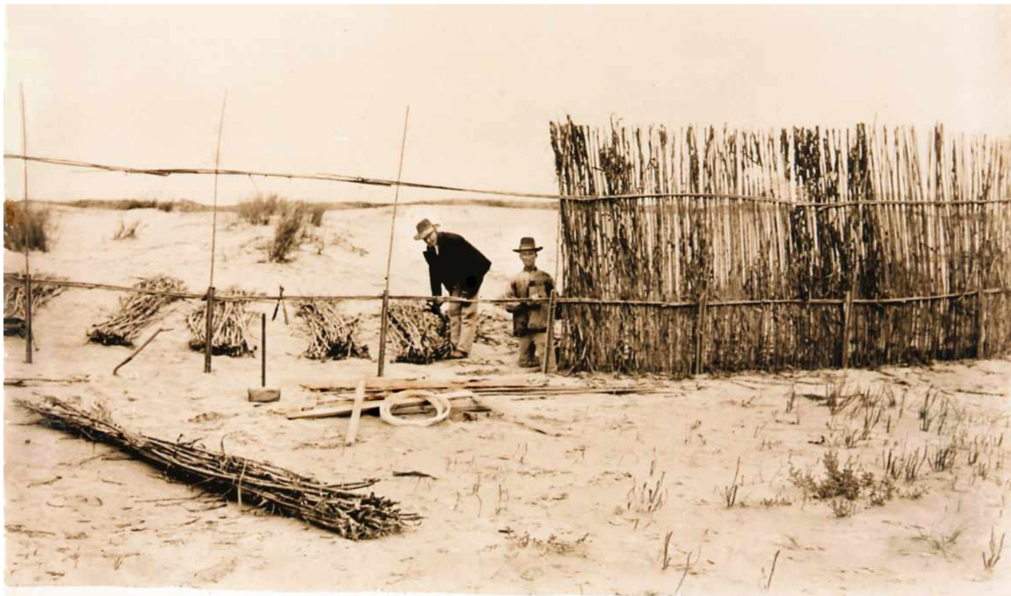
Cañizos para la defensa provisional del jumbo, de las siembras y de los viveros, contra el avance de las arenas Año 1902
