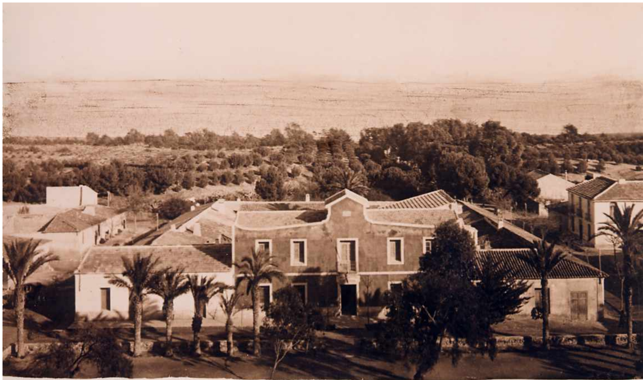
Plaza y casa-Ayuntamiento de Guardamar, y las duncas replantadas. Al fondo el mar. Año 1923.
