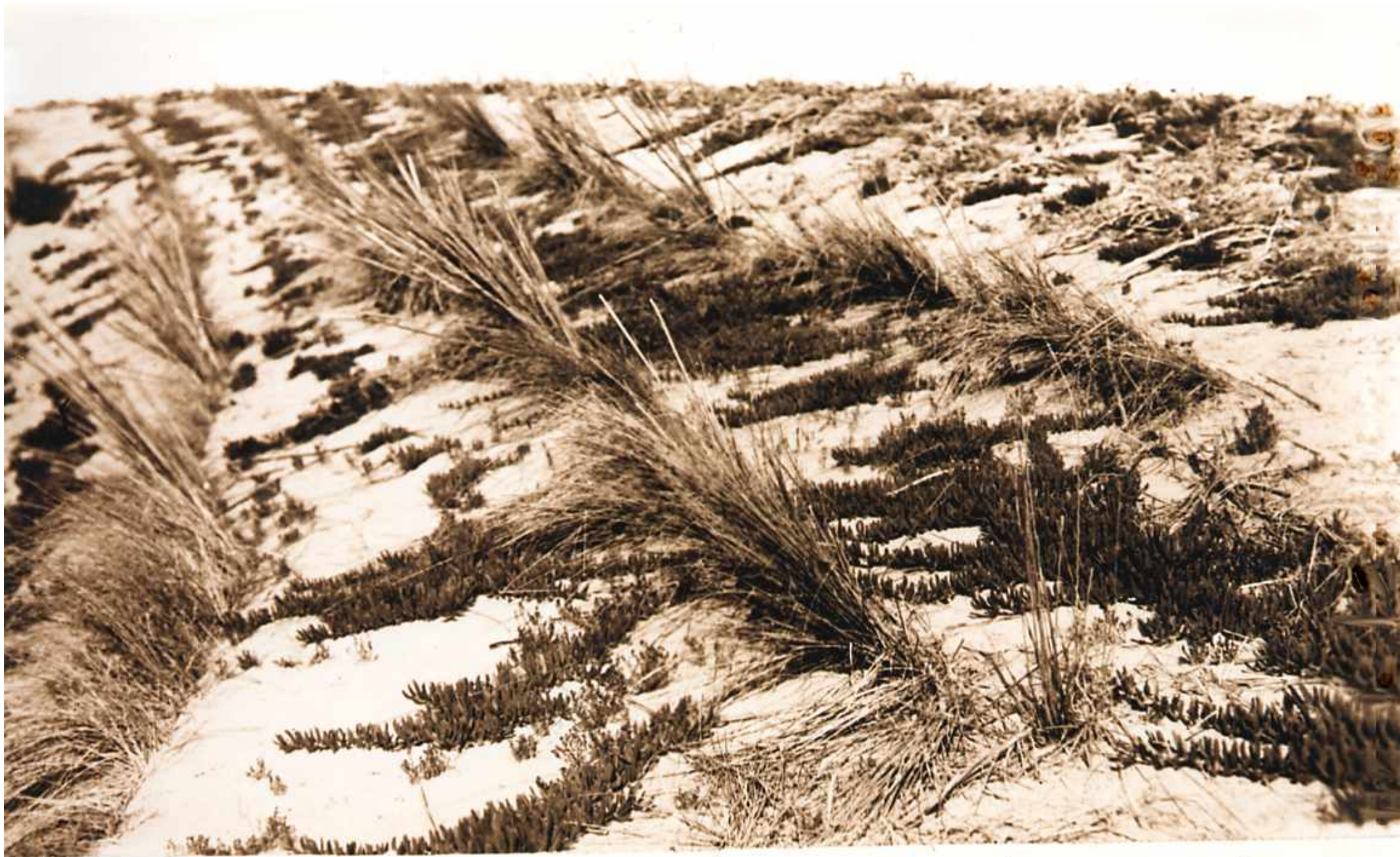
Fijación de fuertes taludes con plantaciones de barrón y mata-euchillo. (Viña de León). Año 1906
