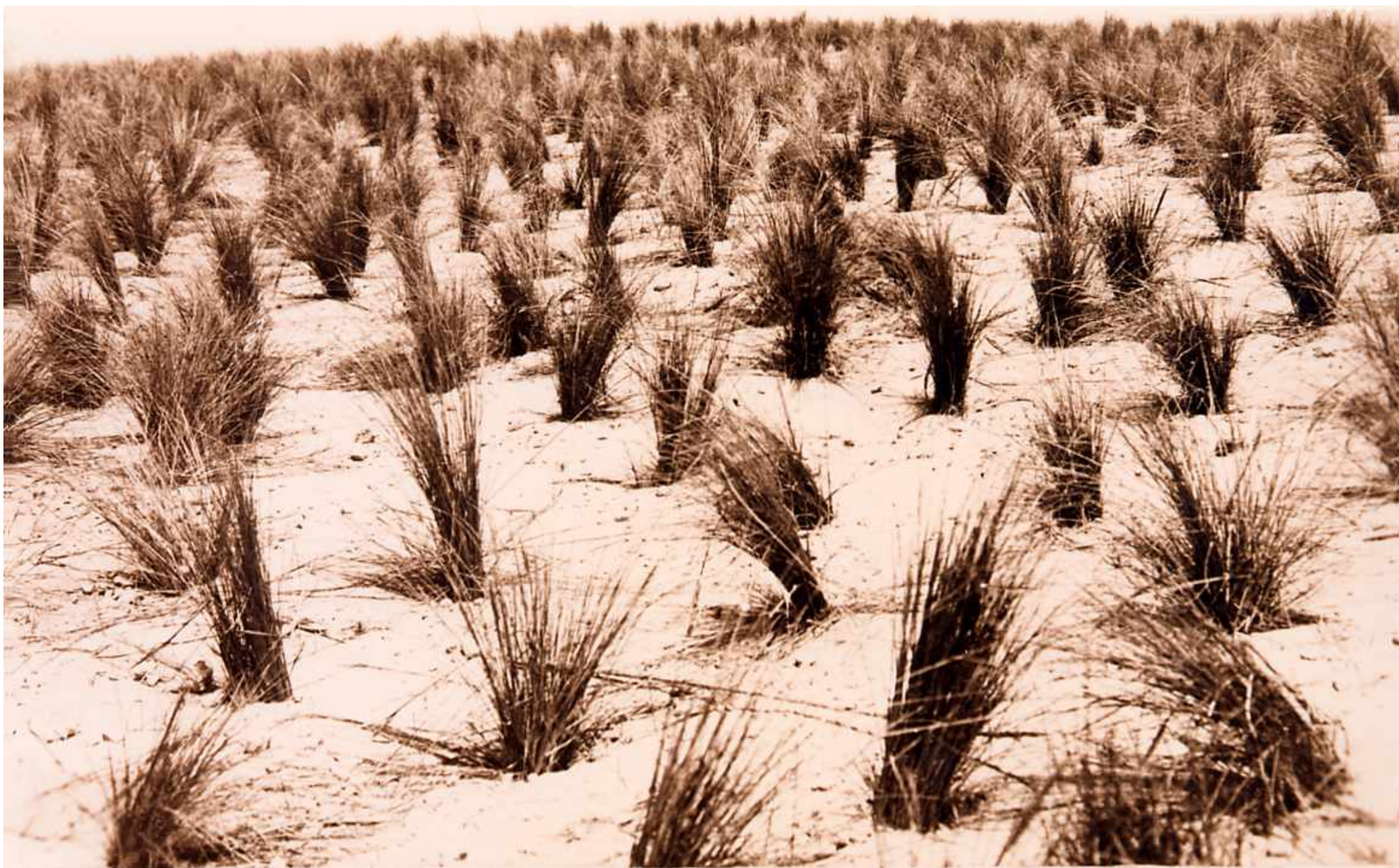
Fijación del suelo con plantaciones de barrón a tresbolillo - Año 1901.
