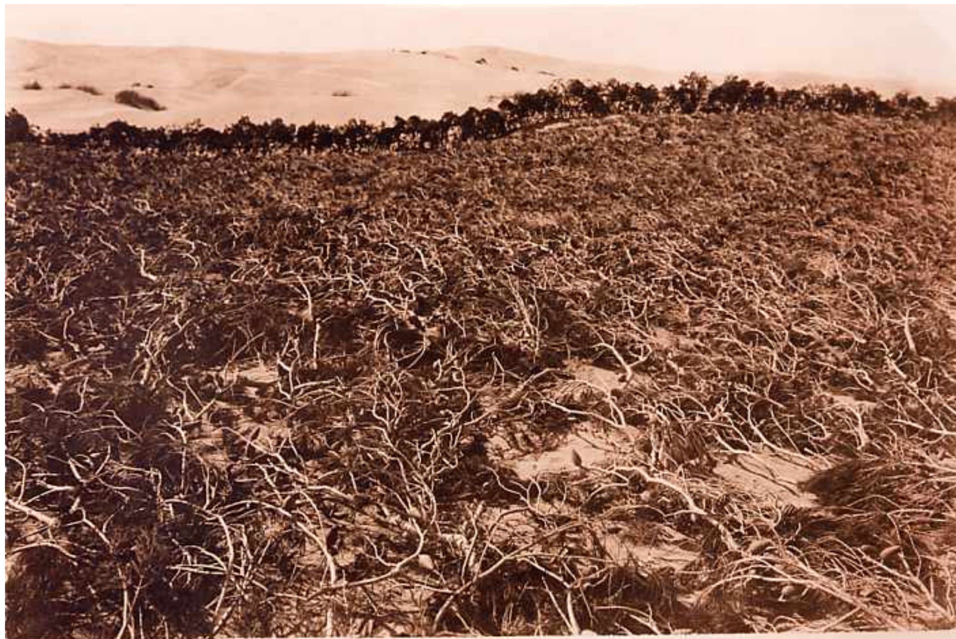
Trozo de arenal sembrado y protegido con cubiertas de ramaje tendido. Año 1902.
