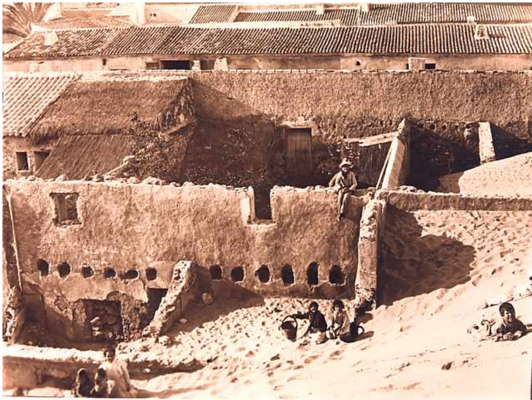
Casas con los techos hundidos por el peso de las arenas. Año 1901.
