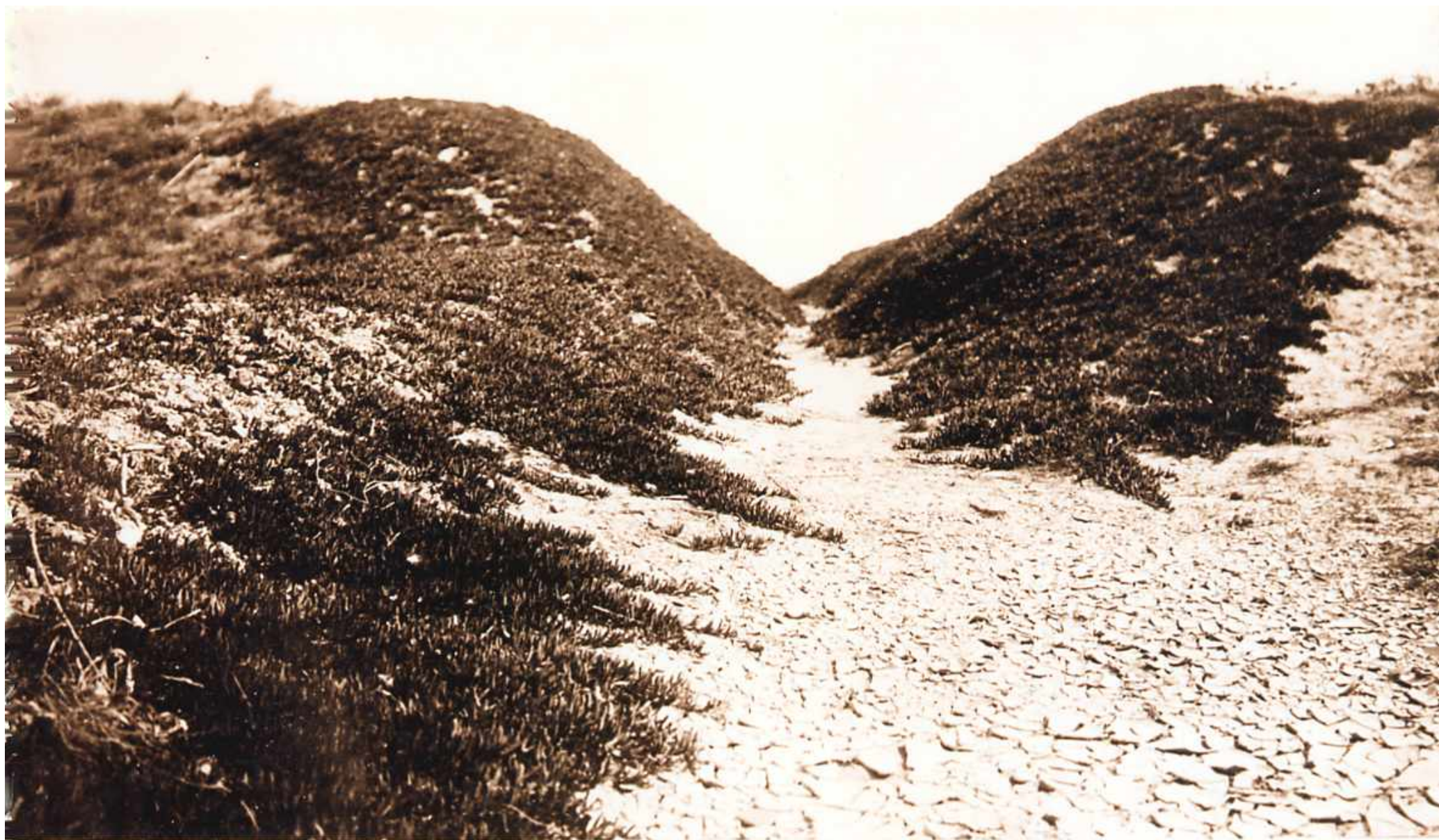
Plantaciones de mata-cuchillo para fijacion de fuertes taludes y formacion de corta-fuegos. Año 1909.
