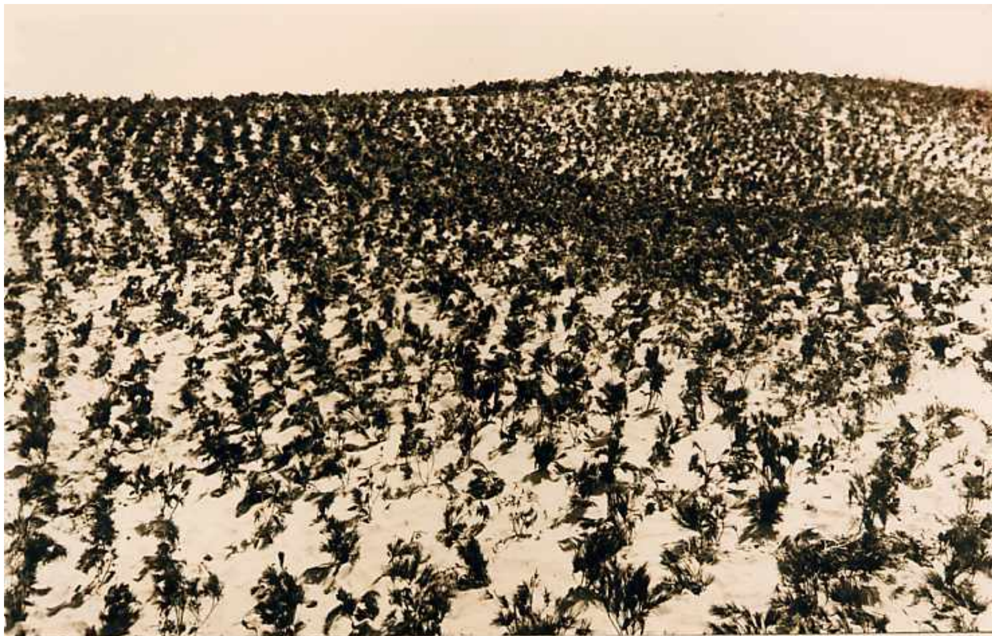
Trozo de arenal defendido con ramas hincadas. Año 1902.
