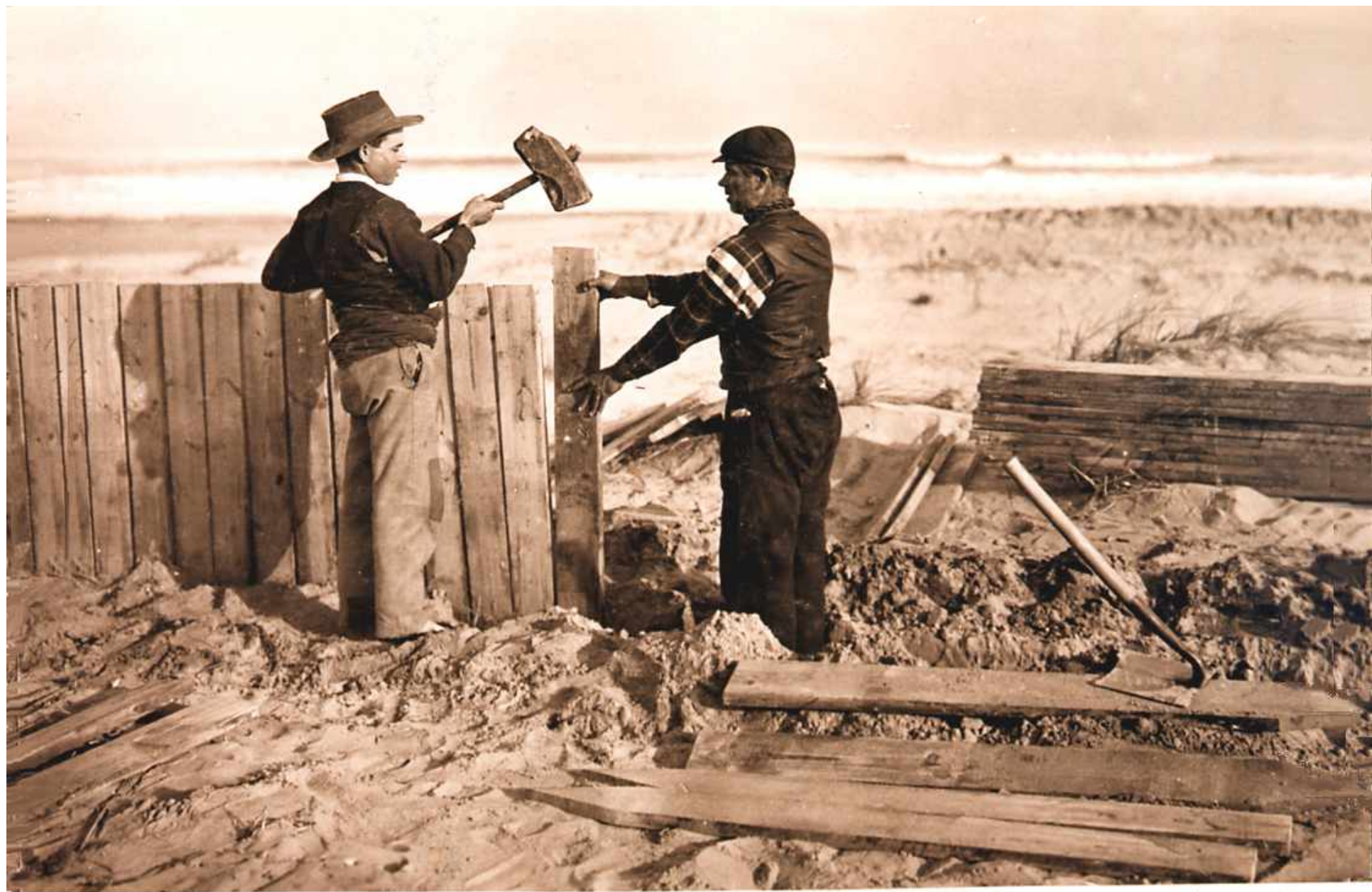
Colocación del tablestacado para formar la diuna litoral o contraduna, y detener en la playa la arena que continuamente arroya el mar en ella Año 1901.
